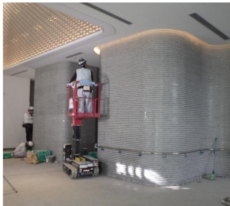
【写真② B棟エントランスホール】
