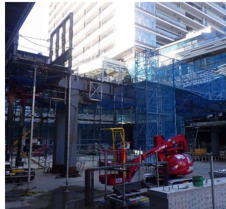
【写真③ ブリッジ工事の様子】
