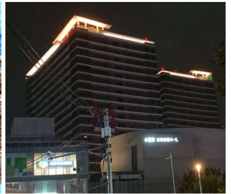
【写真③ 屋上ライトアップの様子】
