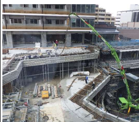
【写真① E棟躯体工事の様子】
