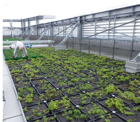
【写真③ 屋上緑化工事の様子】
