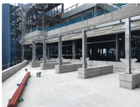
【写真③外装工事の様子】
