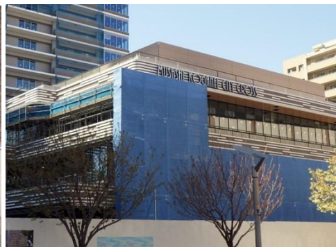
【写真③ 低層外装工事の様子】
