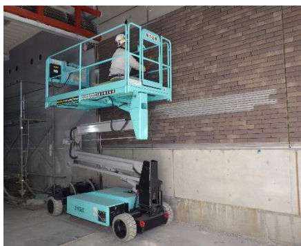
【写真② 外装工事の様子】
