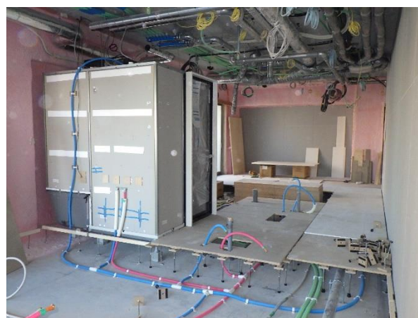
【写真②B棟5階住戸内の様子】
