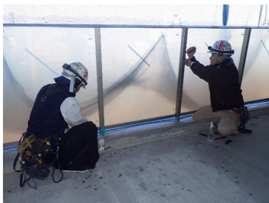
【写真①B棟12階バルコニー手摺ガラスの様子】
