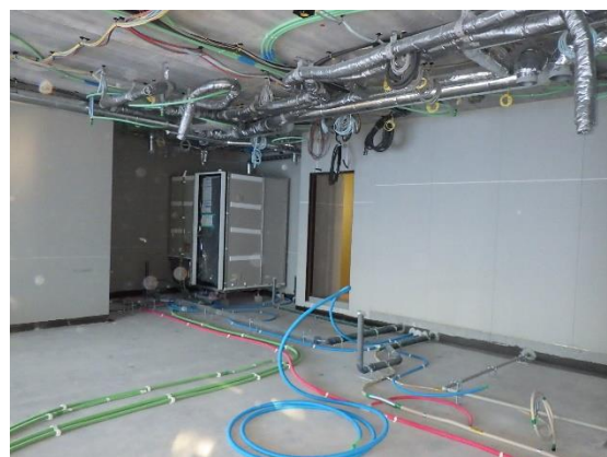
【写真②B棟5階住戸内の様子】
