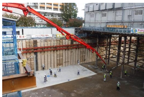
【新築工事の様子①】
