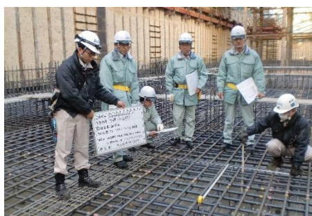
【新築工事の様子②】
