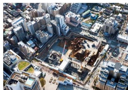
【新築工事の様子③】
