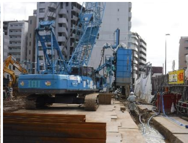
【新築工事の様子②】
