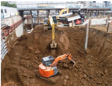
【新築工事の様子①】
